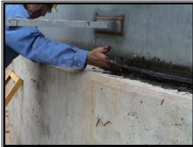
Aplicación manual del protector TEMCOAT.
