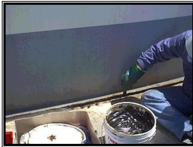
Protección con sellador para concreto
