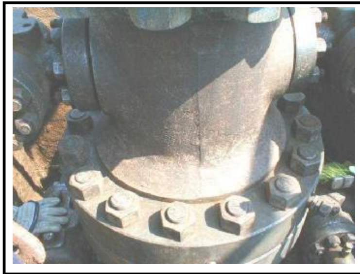
Grado de Limpieza antes de la aplicación del sistema.
