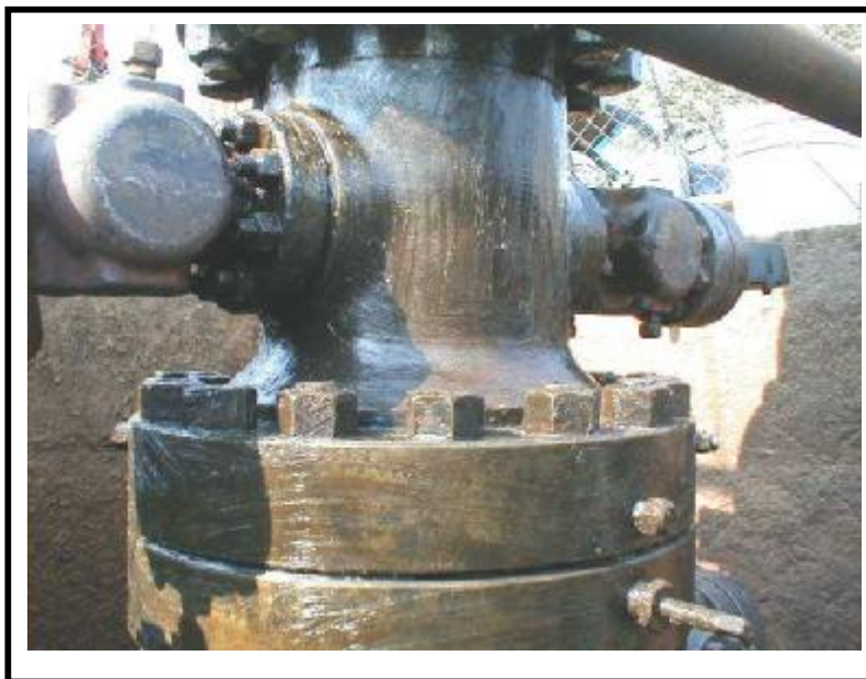
Cabezal de Pozo con la Protección Anticorrosiva TEMCOAT
